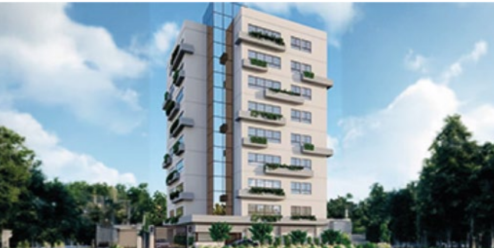
Edifício Joana Bacca está em construção em Campo Grande (MS). Crédito Divulgação
